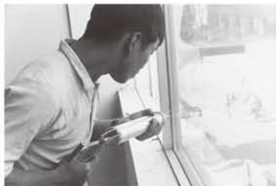
福岡ビルのウェザーバンシーリング施工
