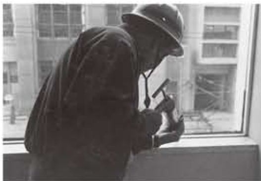
福岡ビルのウェザーバンシーリング施工
