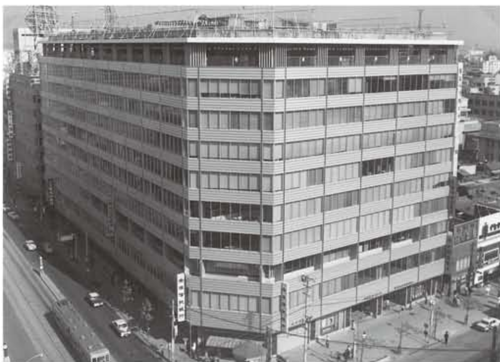
名称 福岡ビル 竣工 1961年12月 間組 (福岡市中央区天神1-11-17)
